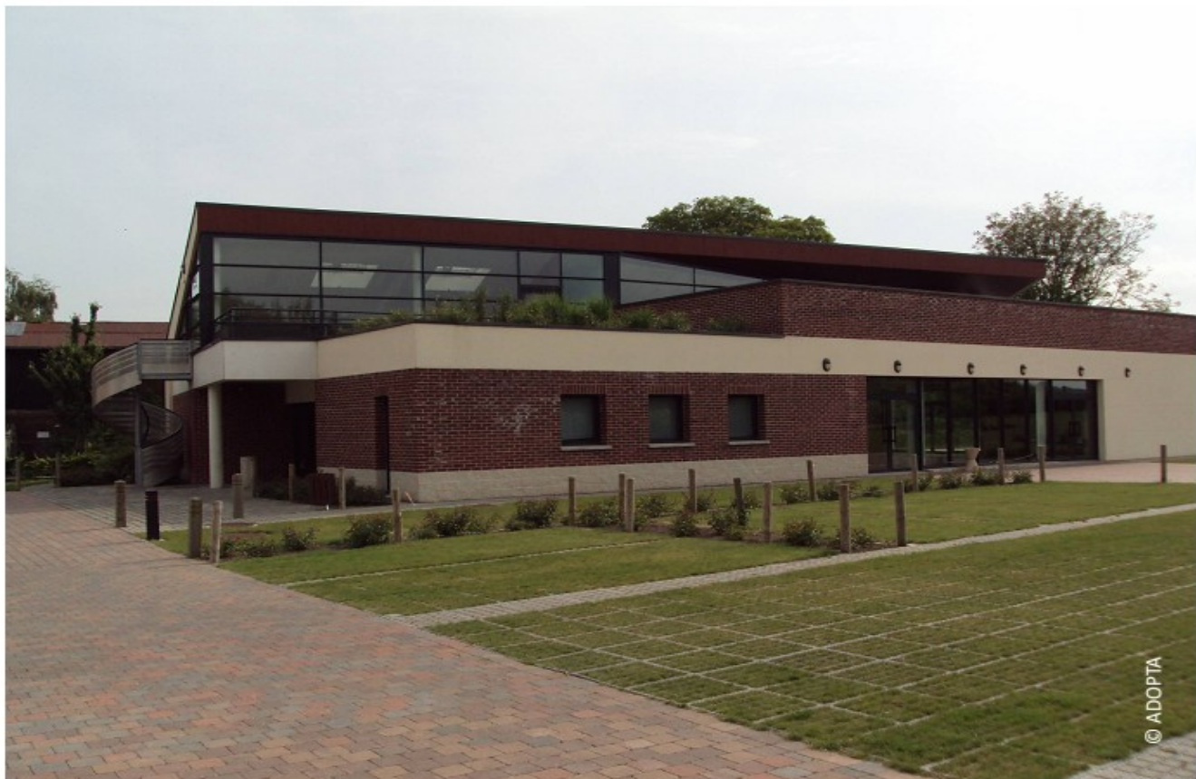
La toiture végétalisée et les dalles-gazon
