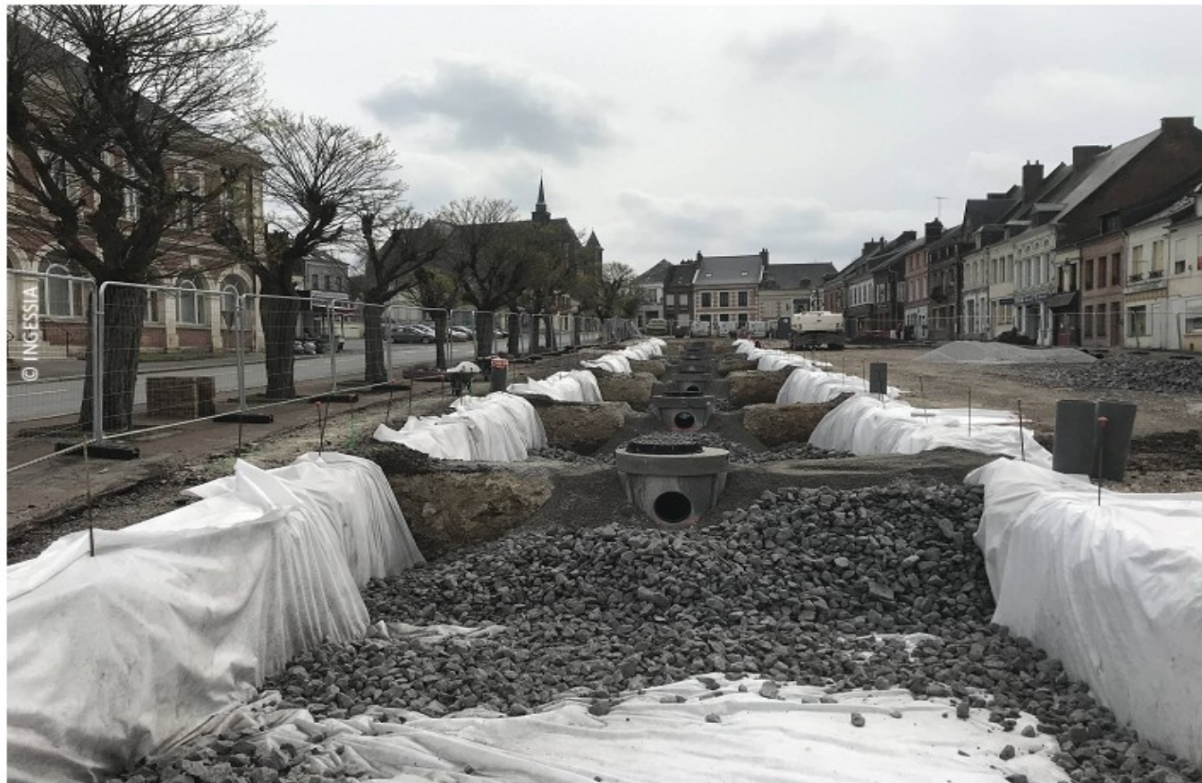
La chaussée à structure réservoir
